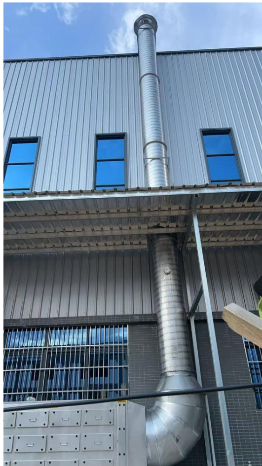
喷漆废气处理设施
