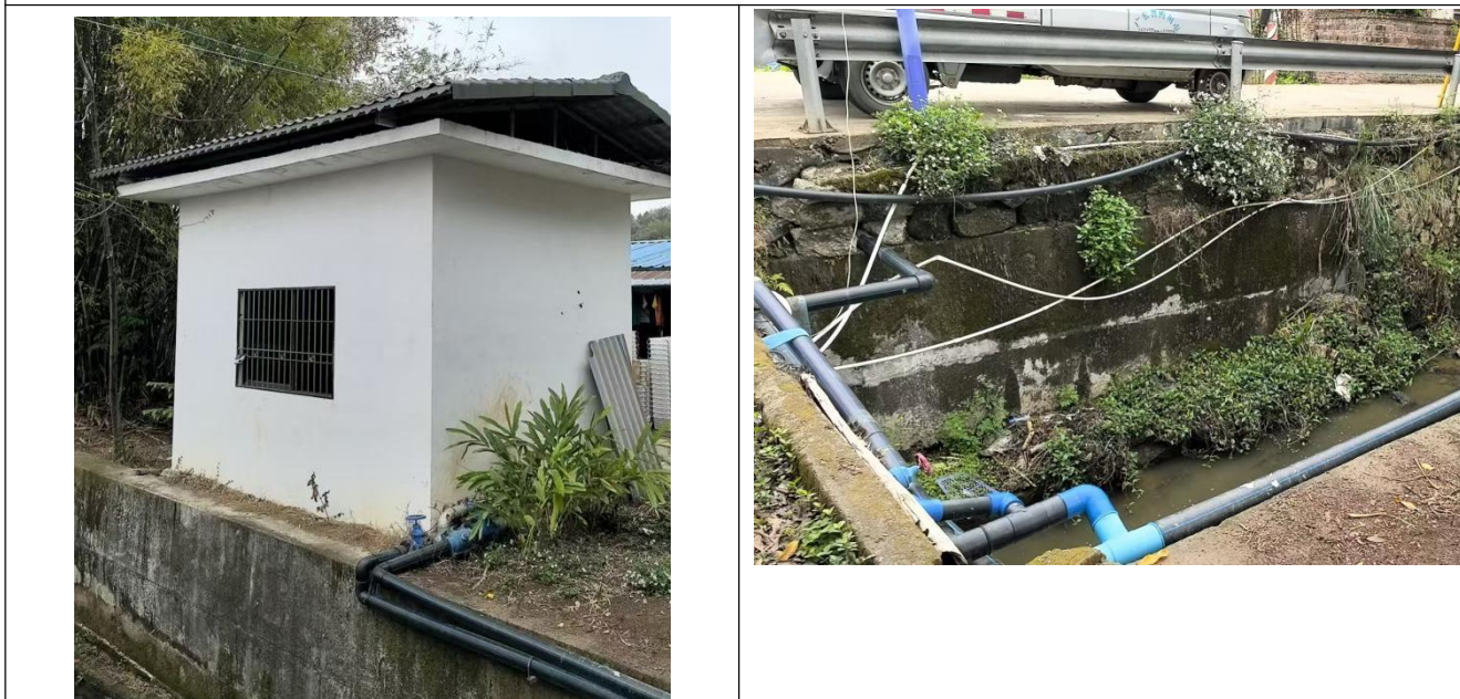
大和村加压泵房
