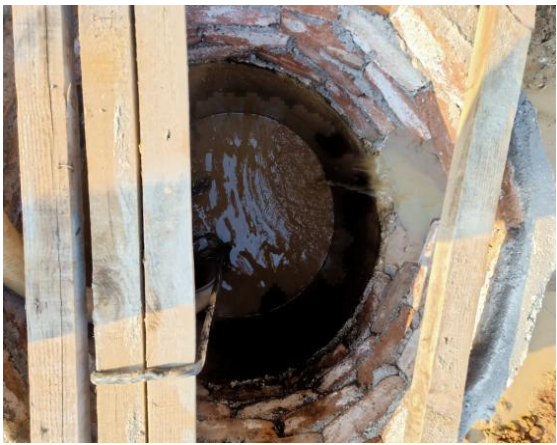
厂区地面水沉淀池
