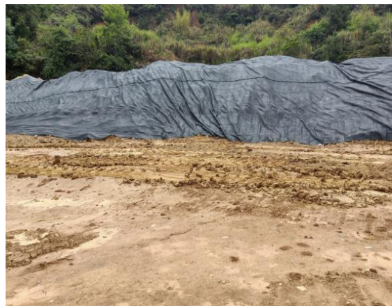
原料堆场遮盖
