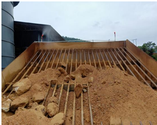
进料口喷淋装置
