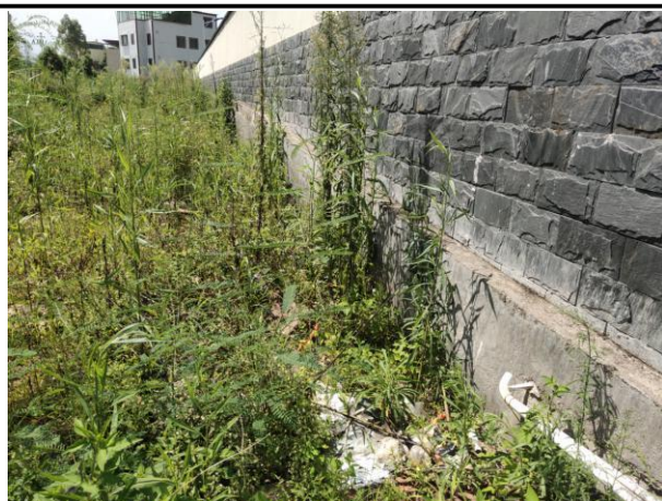
取水泵站区挡土墙（2019 年 9 月）
