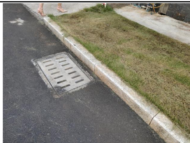
取水泵站区排水沟（2019 年 9 月）
