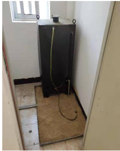
发电机储油间防渗措施
